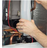
Rimozione collettore fumi
