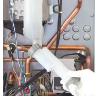
Rimozione sifone condensa
