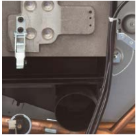
Sblocco raccolta condensa
