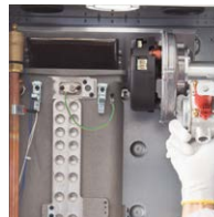
Rimozione del sistema di combustione completo
