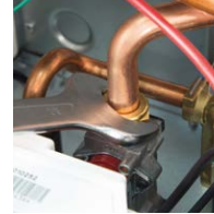
Rimozione del sistema di serraggio della tubazione
