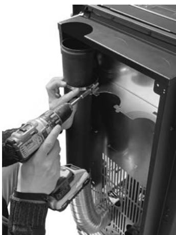
Fig. 63 - Bloccare tubo d.80 mm
