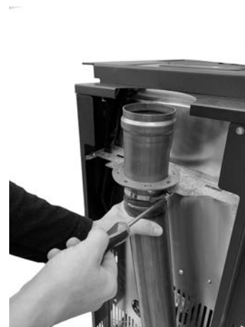
Fig. 42 - Bloccare con fascetta
