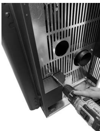
Fig. 57 - Rimozione deviatore
