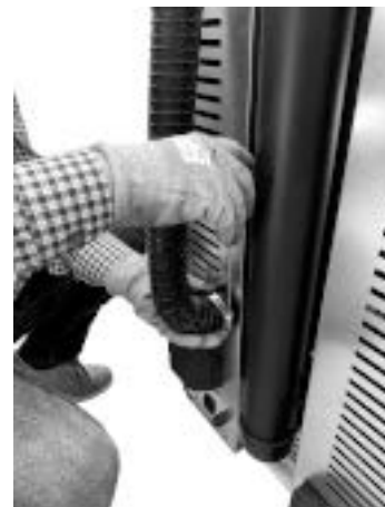
Fig. 76 - Innestare tubo dell'aria comburente
