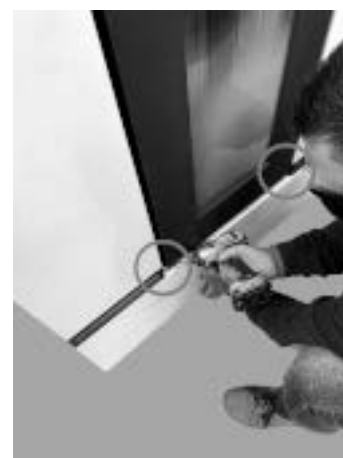
Fig. 47 - Fissare pannello inferiore
