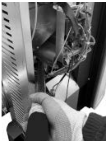
Fig. 130 - Pulizia ventilatore ambiente 1
