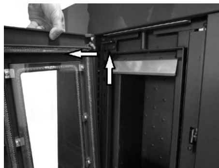
Fig. 20 - Rimozione porta
