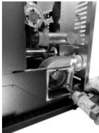
Fig. 82 - Rimuovere viti ventilatore
