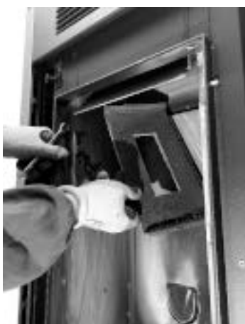
Fig. 121 - Rimuovere la testa del focolare 2
