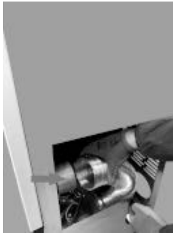
Fig. 91 - Staccare il tubo flessibile
