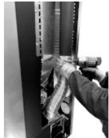
Fig. 86 - Fissare i tubi
