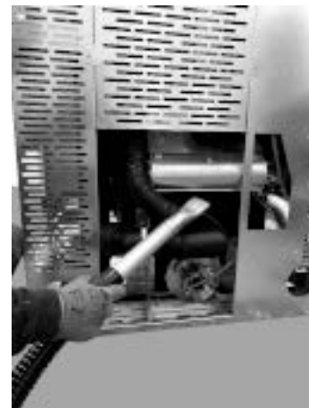
Fig. 131 - Pulizia ventilatore ambiente 2
