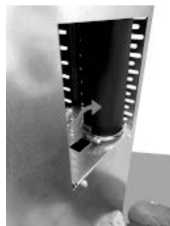
Fig. 103 - Bloccare il tubo canalizzazione
