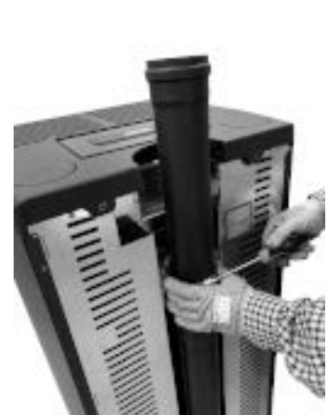
Fig. 73 - Scarico fumi posteriore montato
