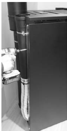
Fig. 29 - Rimuovere viti posteriori
