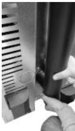
Fig. 50 - Innestare tubo d.80 mm
