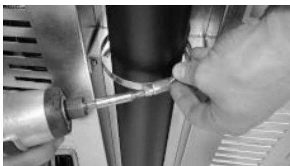
Fig. 52 - Bloccare con fascetta
