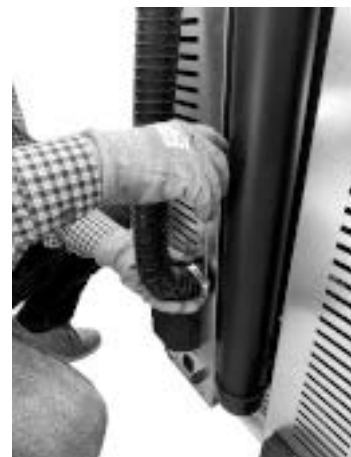
Fig. 51 - Innestare tubo dell'aria comburente
