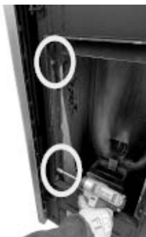
Fig. 76 - Rimuovere viti esagonali
