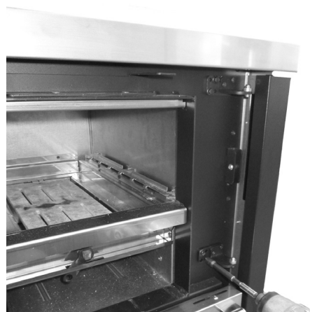
Fig. 26 - Fissare staffa inferiore
