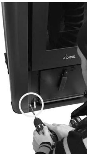
**Fig. 26 - Fissaggio cornice**
