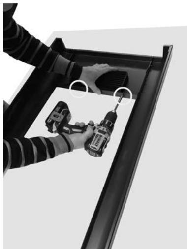
Fig. 24 - Fissaggio della griglia
