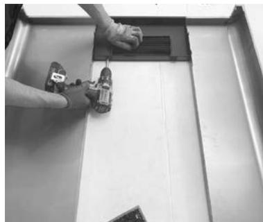
**Fig. 44 - Fissaggio della griglia**
