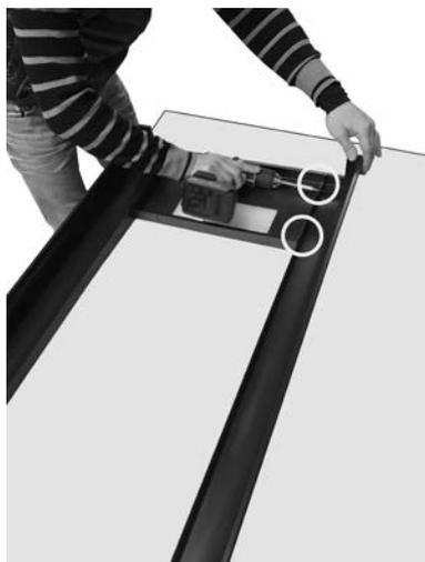
Fig. 23 - Fissaggio del montante
