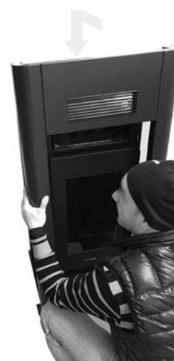
Fig. 25 - Posizionamento della cornice
