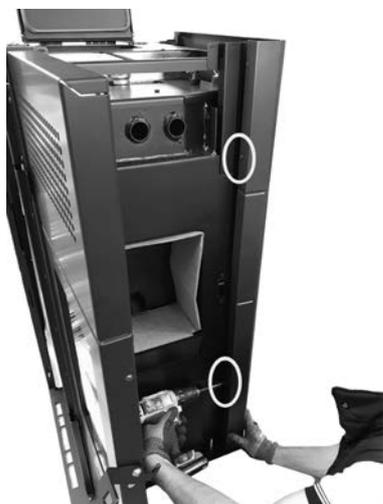
**Fig. 60 - Fissaggio anteriore fianco**
