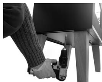
Fig. 19 - Fissaggio stufa
