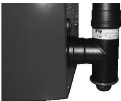
Fig. 64 - Pulizia canale da fumo
