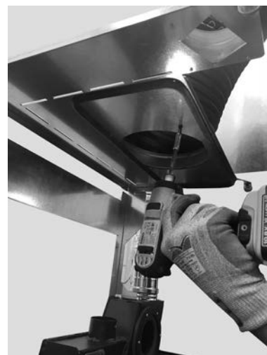
Fig. 63 - Fissaggio tubo flessibile
