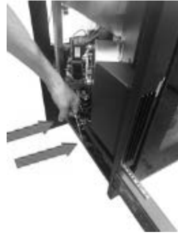
Fig. 21 - Rimozione corpo macchina
