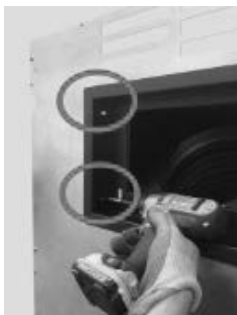
Fig. 64 - Fissaggio esterno botola
