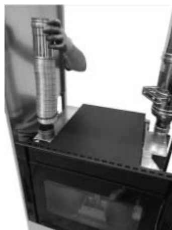
Fig. 57 - Inserimento inserto
