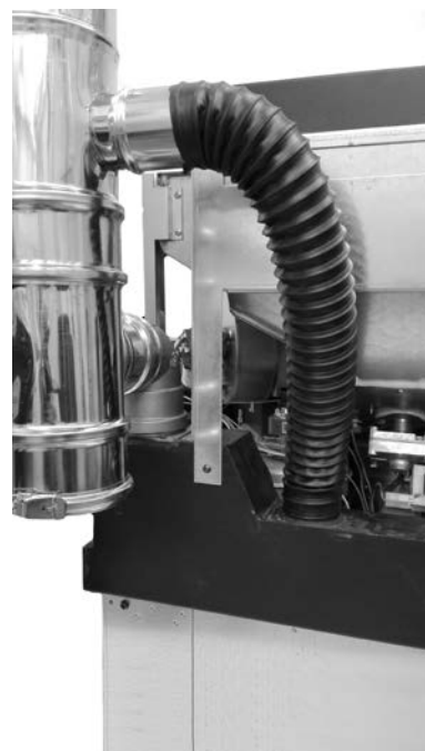
Fig. 75 - Collegamento tubo aria comburente
