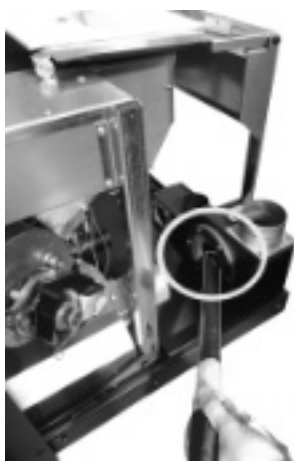
Fig. 113 - Pulizia canale da fumo
