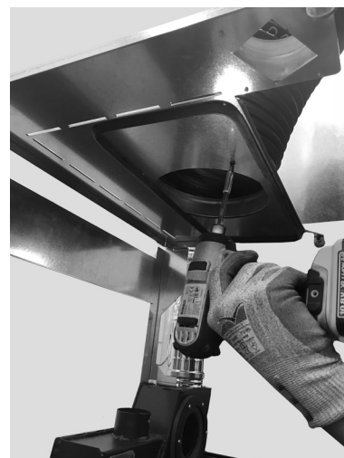
Fig. 67 - Fissaggio tubo flessibile
