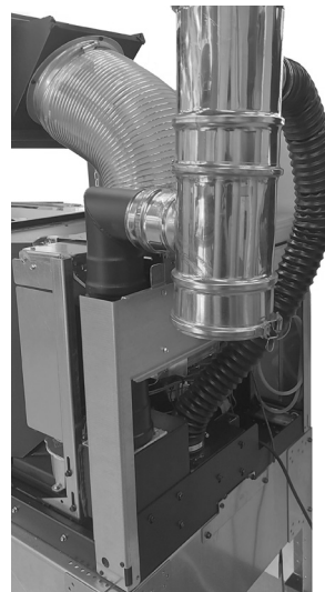
Fig. 78 - Collegamento tubo concentrico + aria comburente
