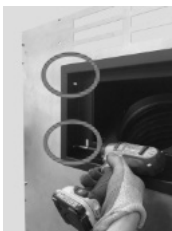
Fig. 68 - Fissaggio esterno botola
