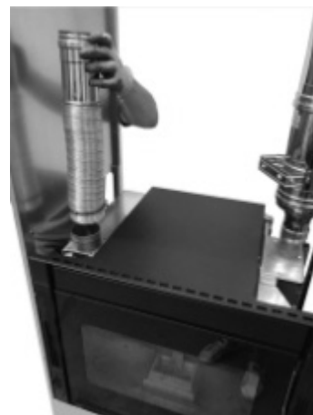
Fig. 61 - Inserimento inserto
