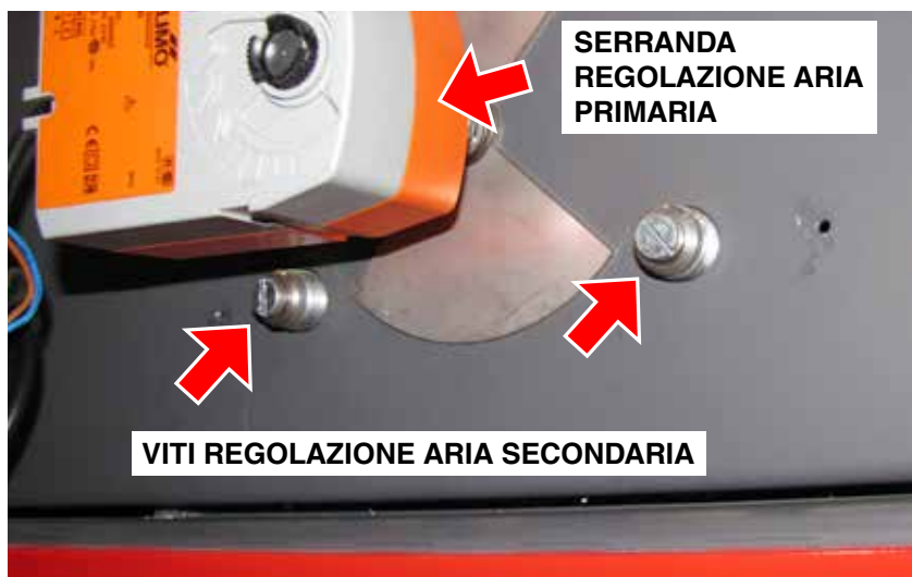
VITI REGOLAZIONE ARIA SECONDARIA
