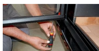
Allentare le viti di fissaggio e rimuovere il fermavetro inferiore
